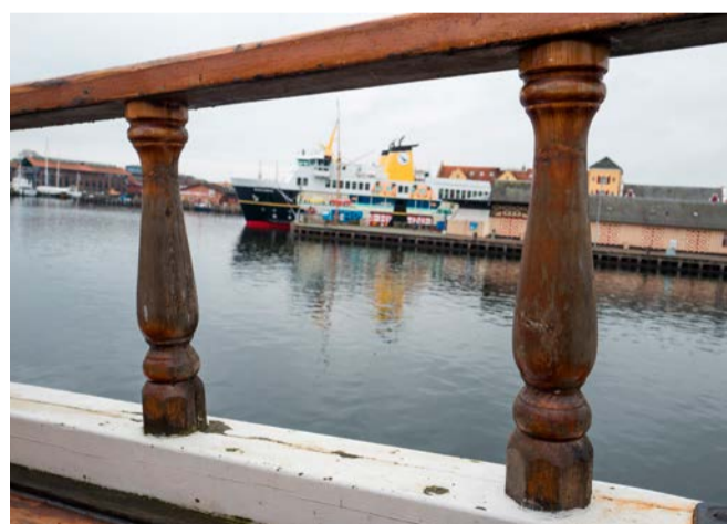
Balustrerne i lønningen var ikke usædvanlige i Ålandsøernes bådbyggeri i 1920'erne. Derfor er de også med på retroungaven af den oprindelige Linden. Foto: Søren Stidsholt Nielsen
